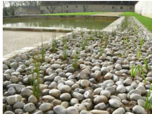
Dispositif de filtres naturels des eaux pluviales
